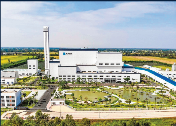
Nhà máy xử lý chất thải rắn Cần Thơ
