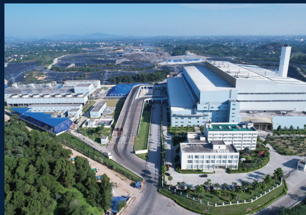
Nhà máy điện rác Sóc Sơn
