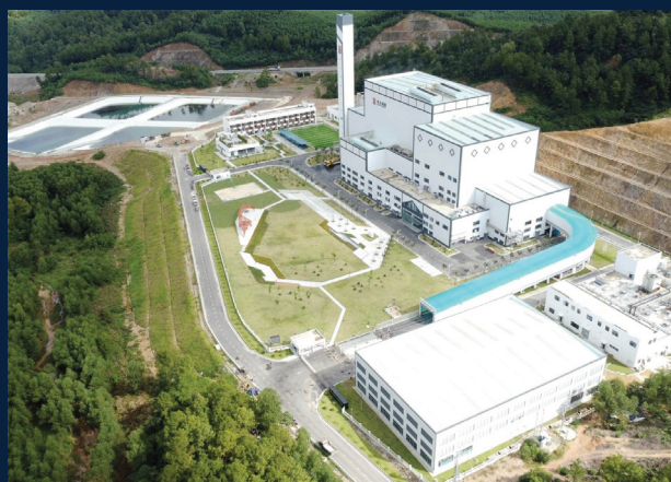
Nhà máy điện rác Phú Sơn
