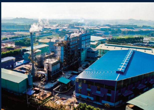
Nhà máy điện rác Ngôi Sao Xanh
